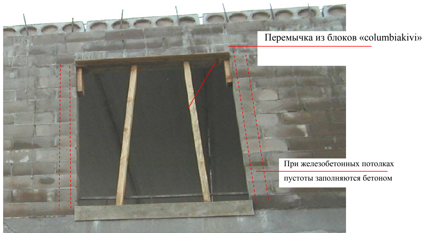
Фото 2. Кладка стены из цементных камней «columbiakivi»
